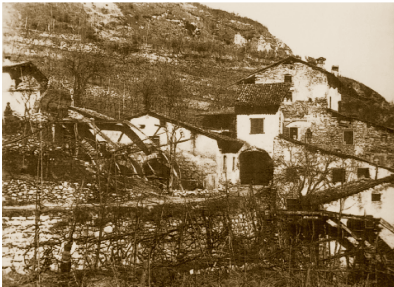
Casa Zambanini ca.1930 con le condotte d'acqua per far funzionare le ruote motrici
